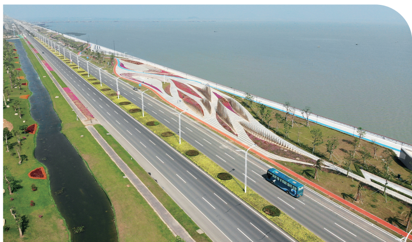
珠海市机场东路海绵城市改造工程
