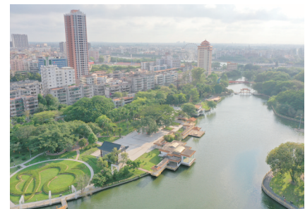
茂名市将海绵城市建设理念融入城市建设发展全过程
