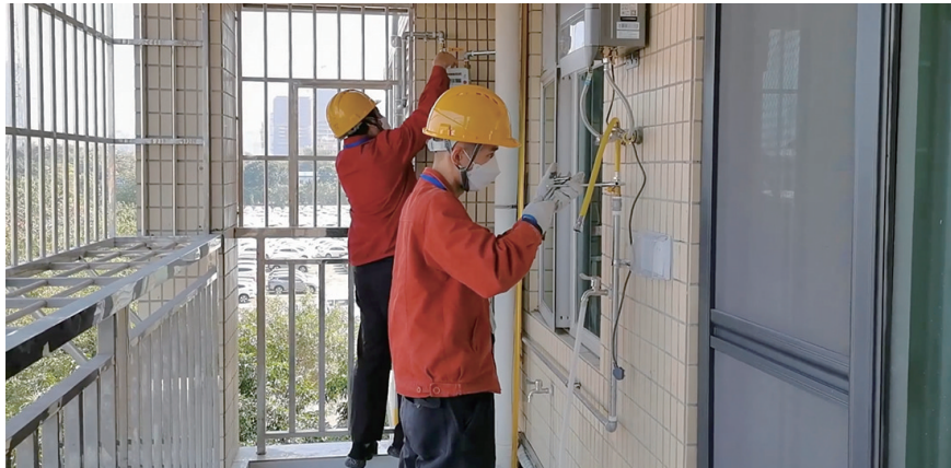
广州市荔湾区工作人员为居民安装燃气管道（通讯员供图）
