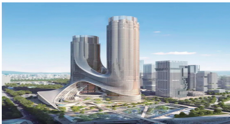
深超总C塔及相邻地块项目（深圳市住房和城乡建设局供图）
