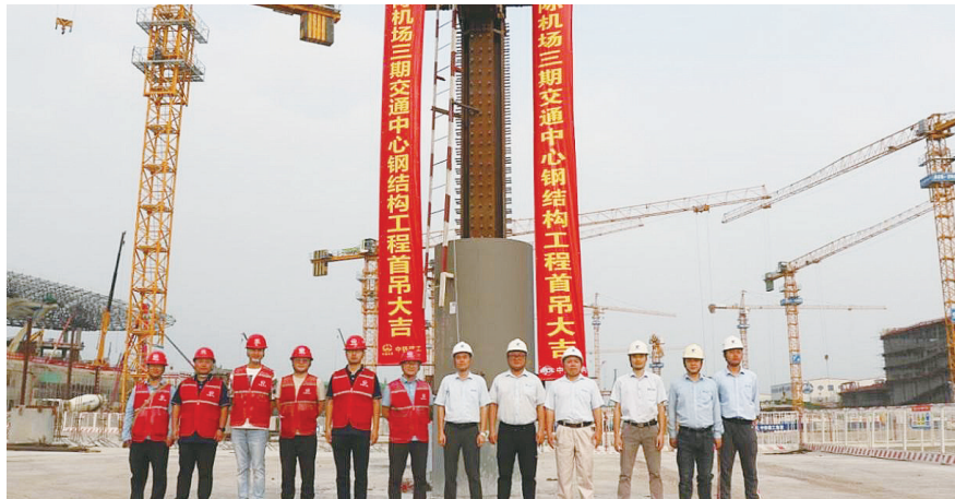
交通中心与共建区首根承重支撑钢骨柱成功完成吊装
