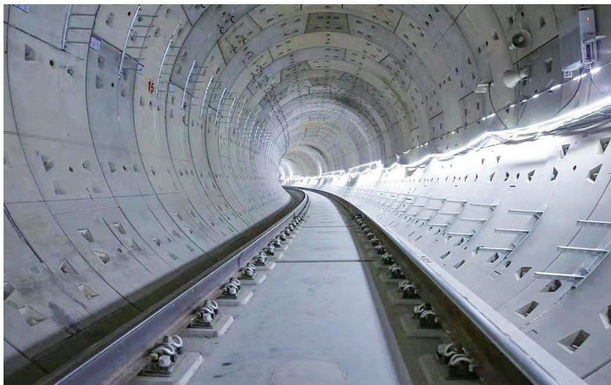
14号线隧道（图源：深圳地铁集团）
