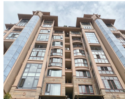
四川某住宅楼，不少窗户被改造成大面积玻璃和窄边框。
