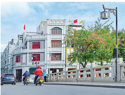
江城区太傅路、河堤路老旧小区改造项目（图源：阳江发布）
