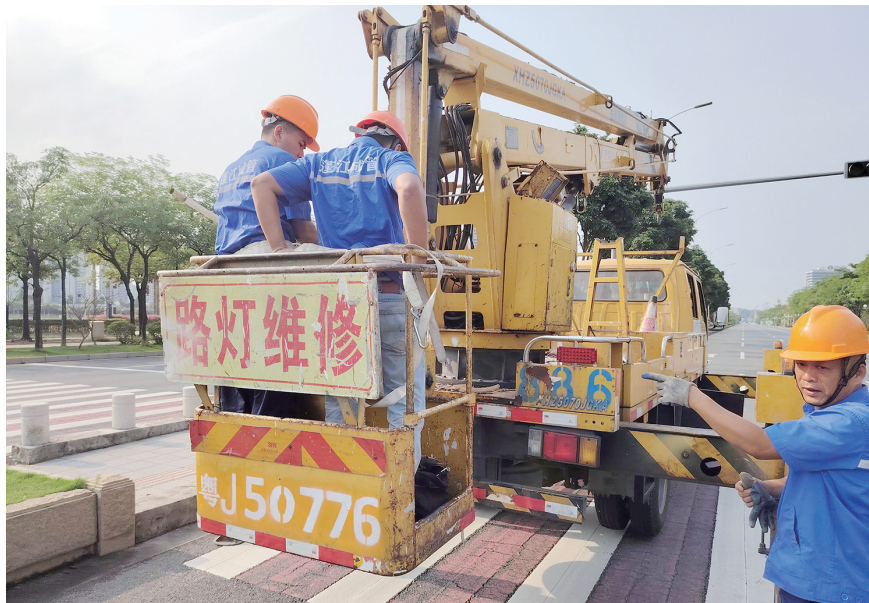
应急抢险队伍正在开展工作（蓬江区城管局供图）
