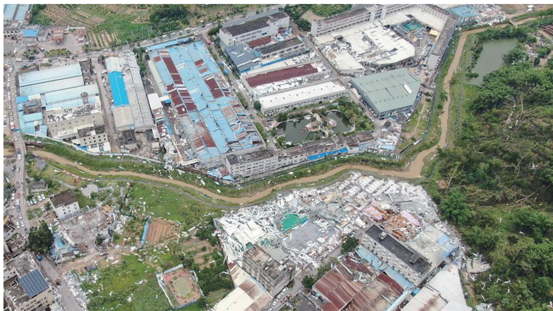
4月27日下午，广州白云区钟落潭镇突遇强龙卷风袭击，造成141家厂房受损。（图源：新华社）
