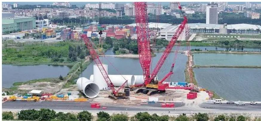
全球单机容量最大海上风电机组正在广东风电临海试验基地进行塔筒吊装。
