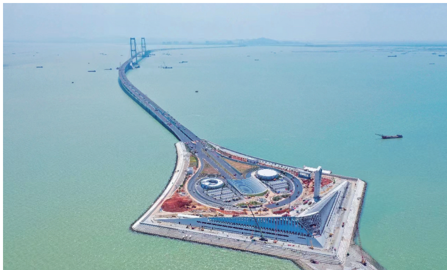
全线沥青路面施工高质量完成（图源：广东交通集团）
