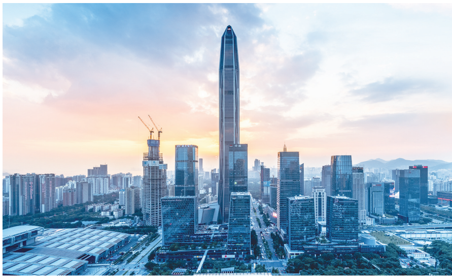
深圳平安金融中心北塔项目
