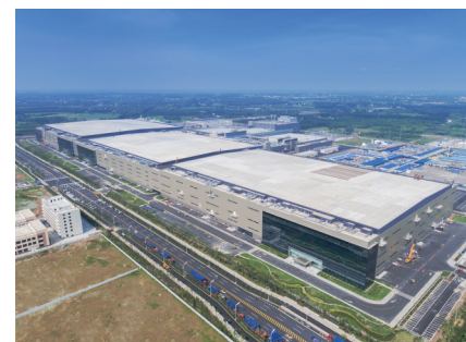
合肥京东方10.5代线项目——全球首条10.5代线厂房，曾获鲁班奖、中国钢结构金奖
