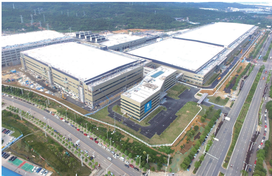
绵阳京东方项目——刷新国内超级厂房单边长度（578米）
