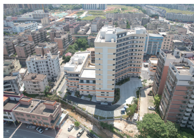
鹤山工业城养老服务中心项目顺利通过竣工验收
