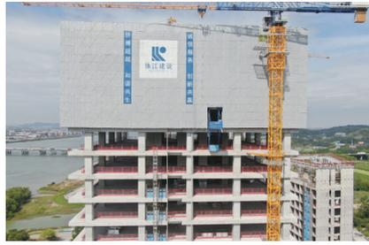
承建大湾区超高层写字楼颐德国际项目采用附着式升降脚手架,大幅降低高处坠物和物体打击事件发生的可能性。
