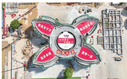
茂名服务区西区服务楼航拍图(图源:广东交通)
