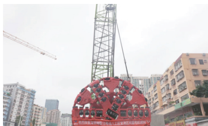
盾构机始发现场 (图源: 深圳地铁)
