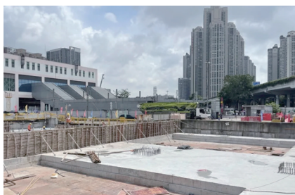
封顶现场 (图源: 广州地铁)
