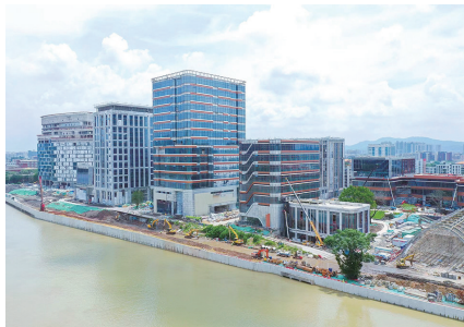
堤防加固工程顺利完工
