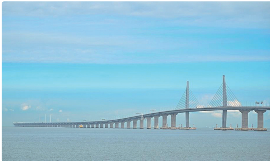
港珠澳大桥（图源：中新社）
