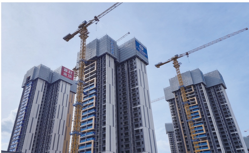
白云机场三期新一批共33栋安置房集中封顶 唐培峰/摄
