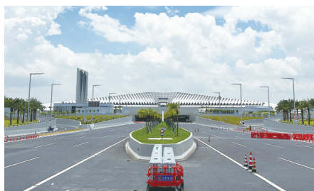
深中通道西人工岛沉管隧道入口 (吕传龙摄)
