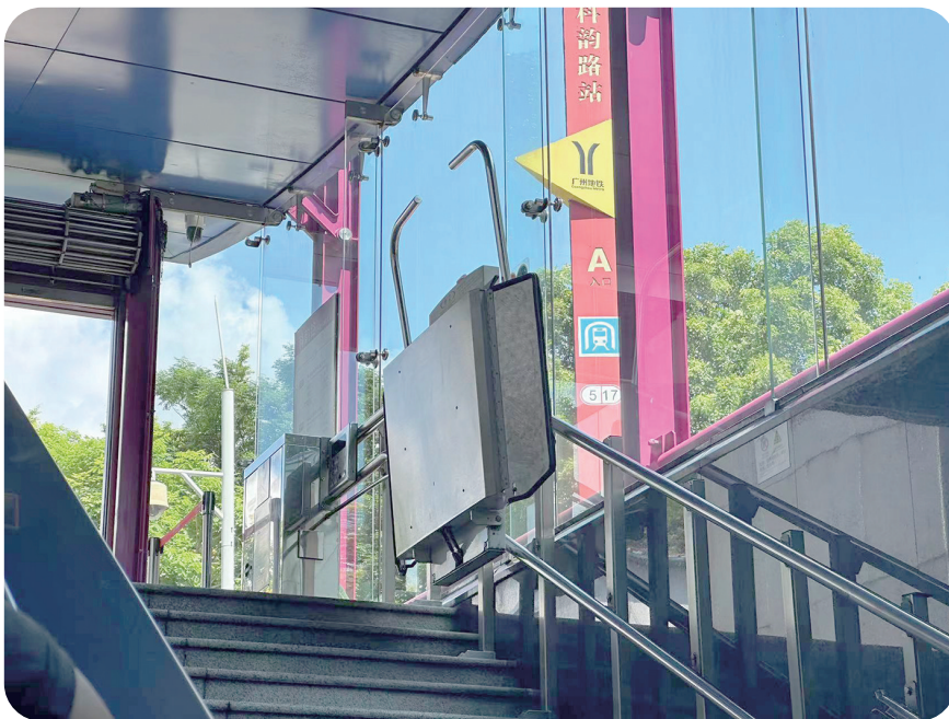
广州地铁入口处设有无障碍设施 刘畅摄
