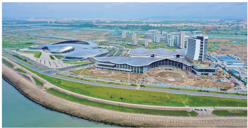
正在加紧建设的汕头国际会展中心（图源：汕头政府网）
