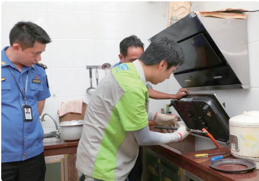
燃气公司工作人员免费为用户更换金属软管（图源：东莞市城管局）
