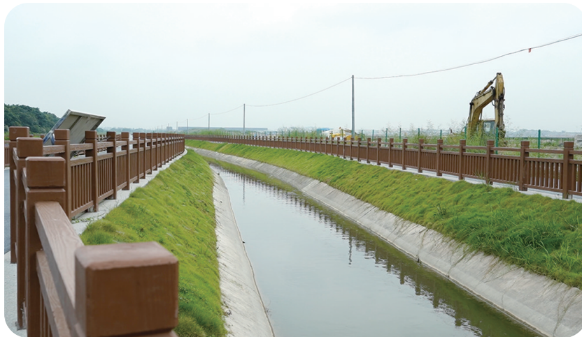
白云机场三期场外排渠改道工程 刘畅摄
