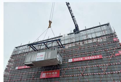
↑↓梅林路6号保障性住房项目首件混凝土模块吊装现场
