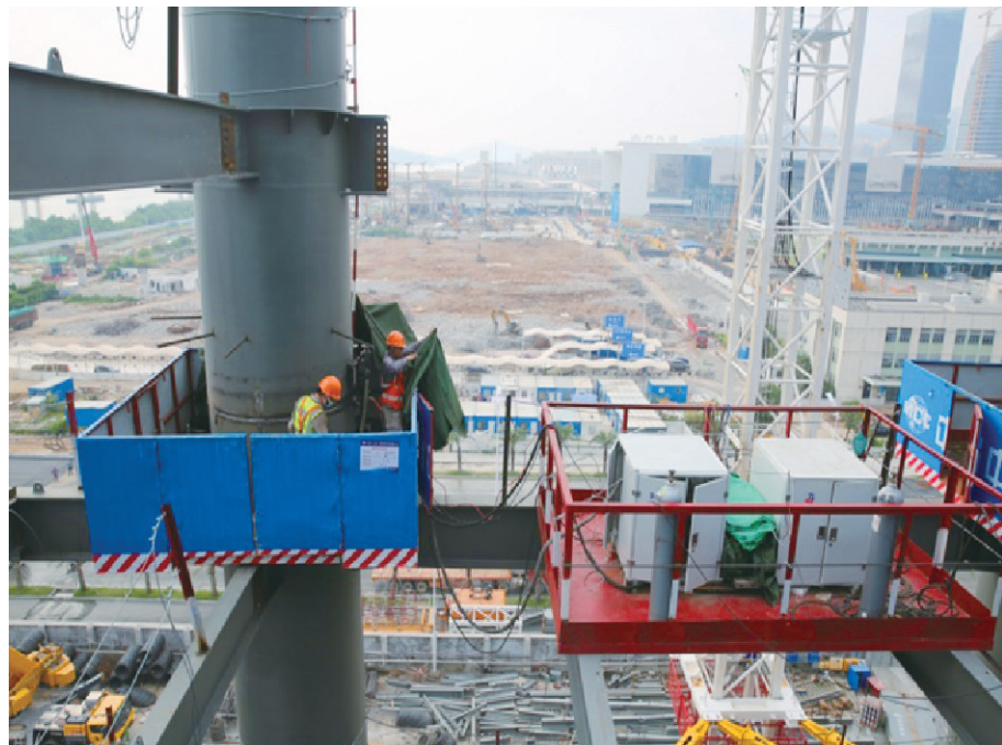
焊接机器人现场焊接
