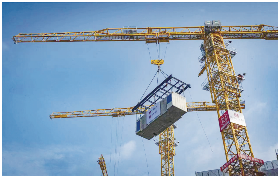
深圳龙华樟坑径地块项目施工现场
