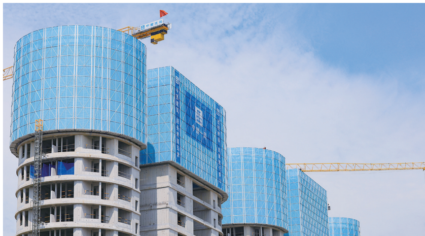
东莞OPPO滨海湾高级人才房, 项目体量大、结构复杂、施工难度大, 外形为椭圆和心形, 别具特色。
