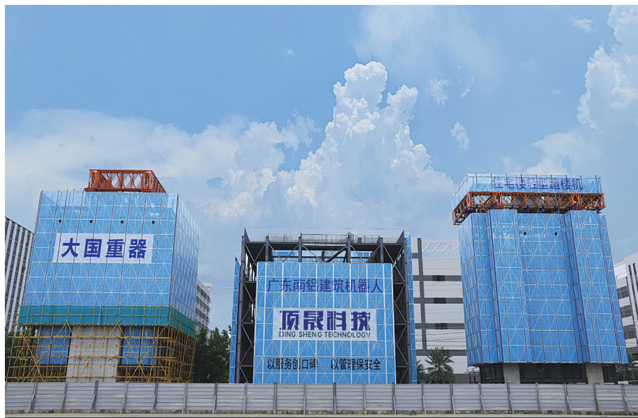
全国首个1:1建造的住宅楼轻型造楼机和商业楼重型造楼机样板工程
