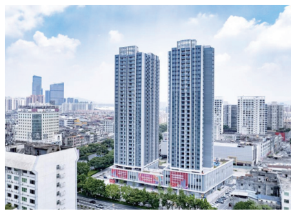
建鑫·荔棠雅苑项目实景图
