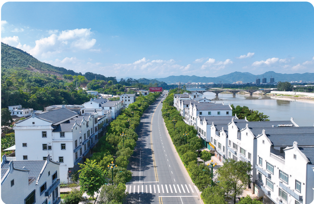
梅州梅县区雁洋镇房屋外立面提升样板
