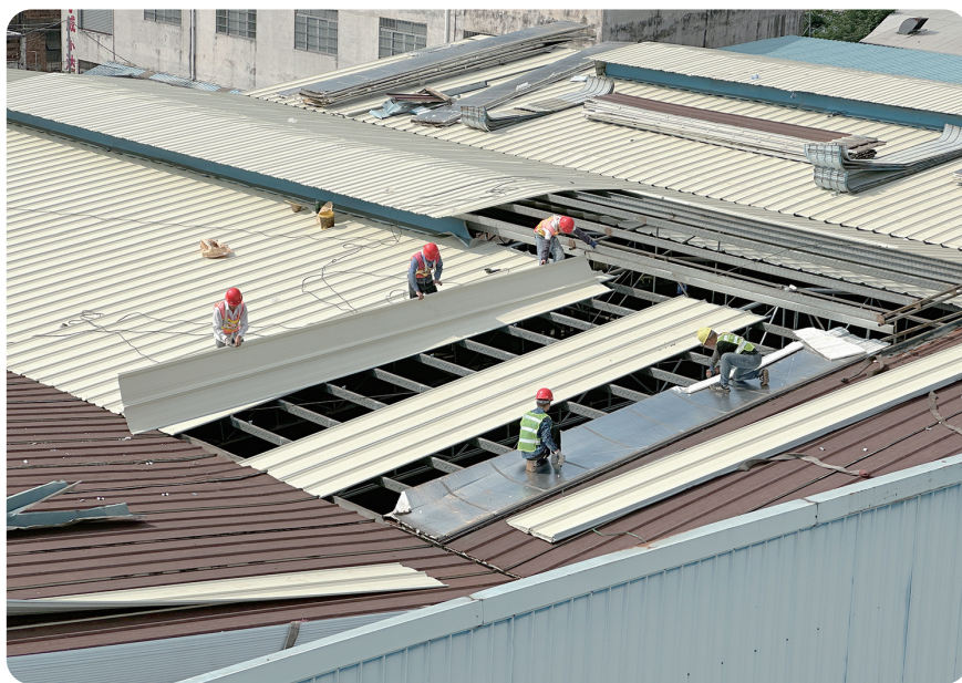
铁锈皮屋拆除现场（图源：禅城城管）
