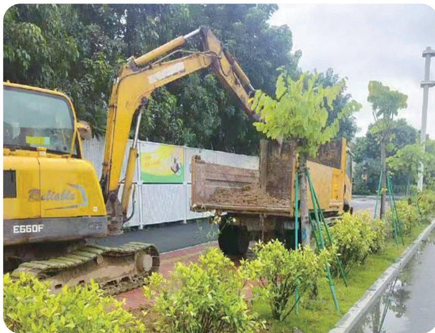
该案例中的建筑垃圾来自乾务镇某路灯项目工地 (通讯员供图)
