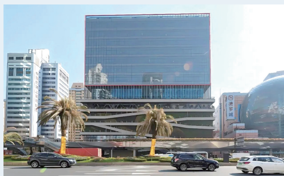
上海徐家汇 T20 大厦 (图源: 上海徐家汇商圈)
