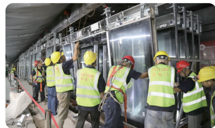
施工现场（图源：广州地铁）
