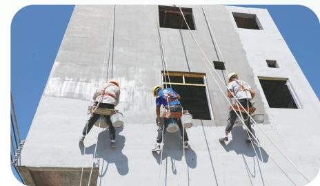
施工人员使用喷涂工艺对农房外墙进行改造
