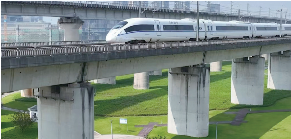
佛山高铁公园（图源：佛山市城管局）
