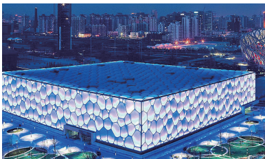
国家游泳中心水立方采用“空腔内透光”的照明方式（图源：中照网）
