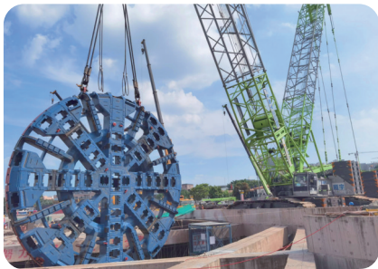
项目施工现场（通讯员供图）
