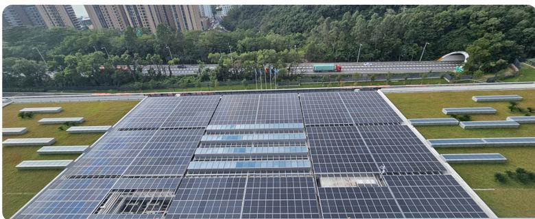
华大基因中心项目采用了光伏建筑一体化施工技术
