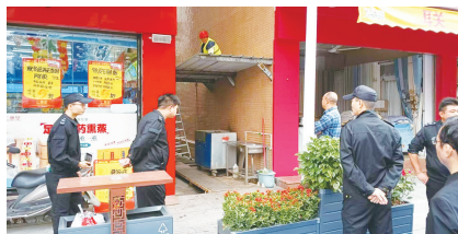
工作人员正在拆除乱搭建铁棚构筑物（黄阁镇城乡管理办供图）
