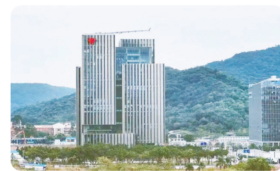
白云迎来广州首栋高层近零能耗建筑(图源:羊城派)
