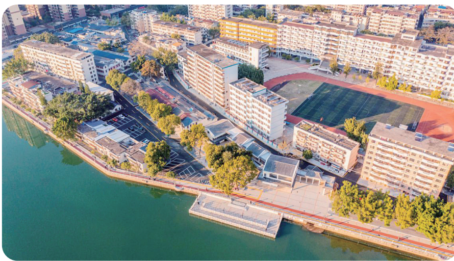
韶关市始兴县丰收林业小区改造后(图源:省住房城乡建设厅)
