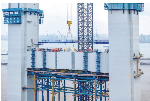
狮子洋大桥完成首道钢横梁架设（通讯员供图）
