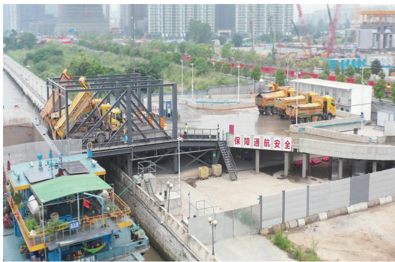
建筑垃圾运输船舶正在临时装卸点装载工程渣土（广州市城管局供图）
