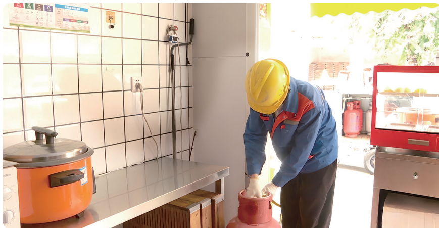
工作人员对燃气瓶灶管阀进行细致检查(图源:广州市白云区城管局)
