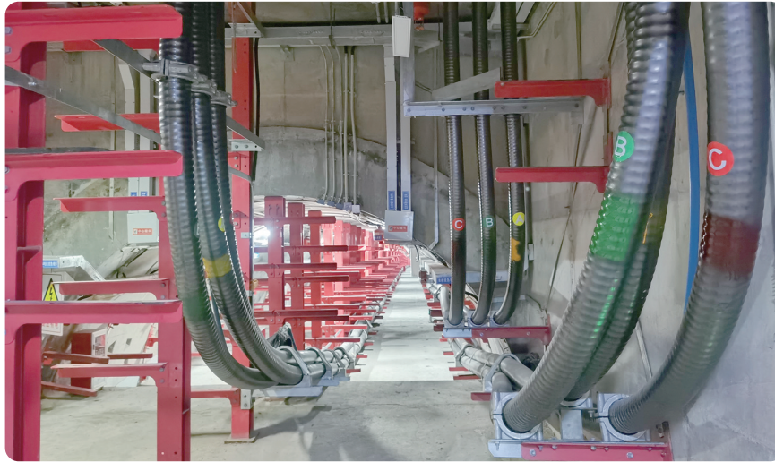
环城管廊电力管线入廊（通讯员供图）
