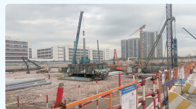
南沙科创谷项目2#地块深厚淤泥地层桩基施工现场（通讯员供图）
