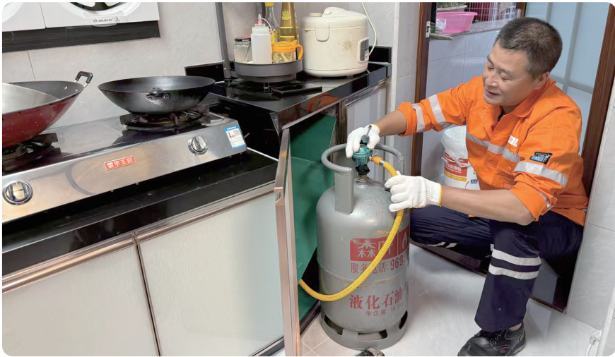
燃气企业免费为符合条件的居民用户更换金属包覆软管（通讯员供图）
