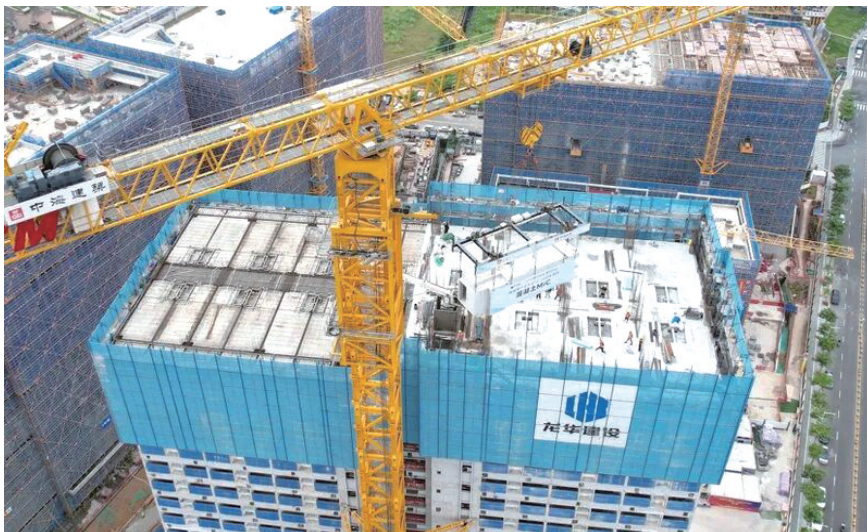
深圳龙华区福城南产业片区12-16宗地项目，728个模块构建出目前全国最高的模块化产业宿舍（图源：深圳发布）
